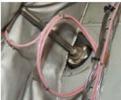
Termoelement typ N med rosa kabel är dominerande temperaturgivare hos Alstom.
